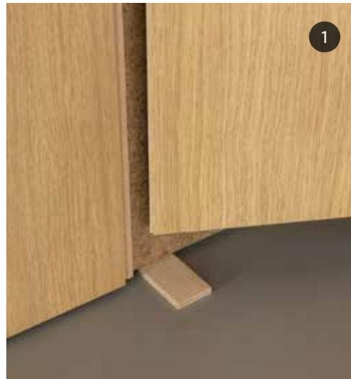
Terminez par le panneau scié sur mesure et dont le côté languette s'encliquette dans le panneau correspondant. De la sorte, le bord droit se place dans l'angle. Si nécessaire, sciez encore un peu le panneau pour avoir assez de jeu.
