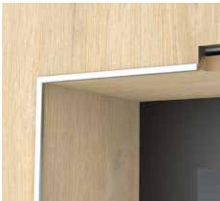
Finition fenêtre avec profilé angulaire en aluminium.
