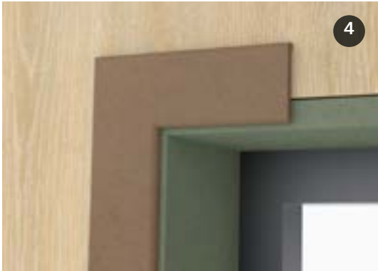
Finition fenêtre avec MDF et moulure de fenêtre.
